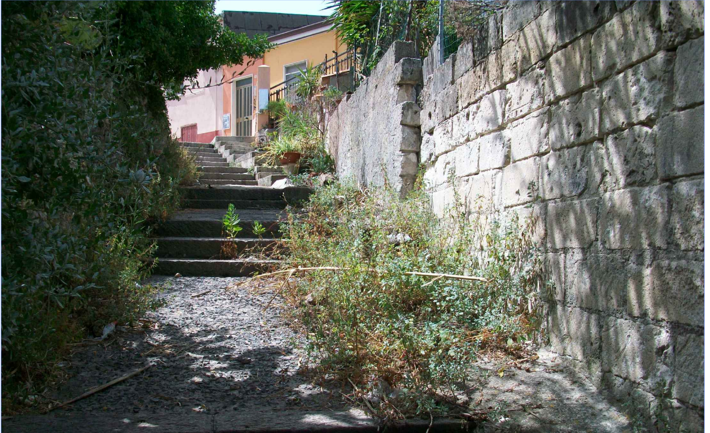
Foto 5 - scalinata ingresso dalla Via Vitt. Emanuele
