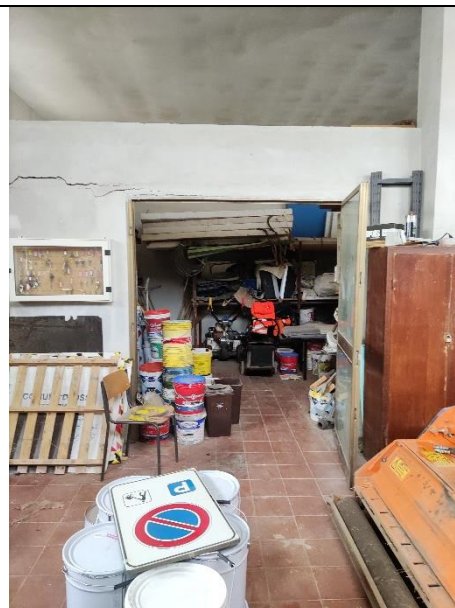
Figura 12 - Edificio esistente primo blocco: ingresso deposito
