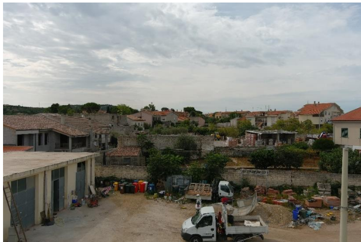
Figura 7 – Visione di insieme dell'area esterna prospiciente il fabbricato esistente in corrispondenza della via di accesso
