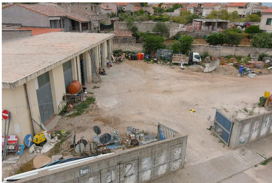
Figura 3 – Cannello esistente di accesso sulla viabilità principale in via Petrarca
