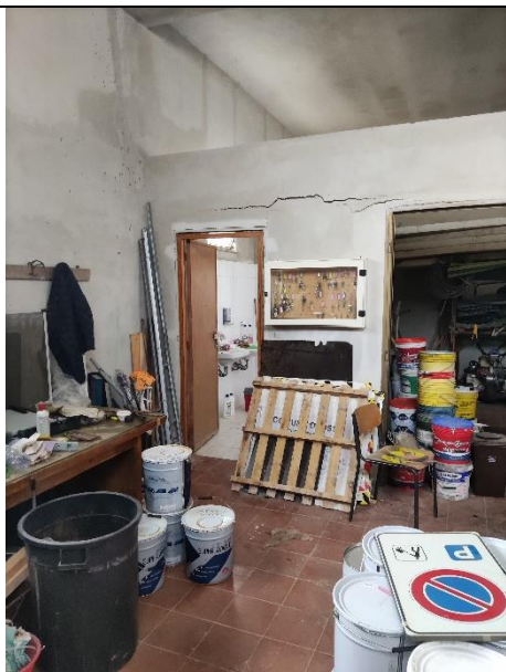
Figura 11 – Edificio esistente primo blocco: ingresso antibagno e deposito
