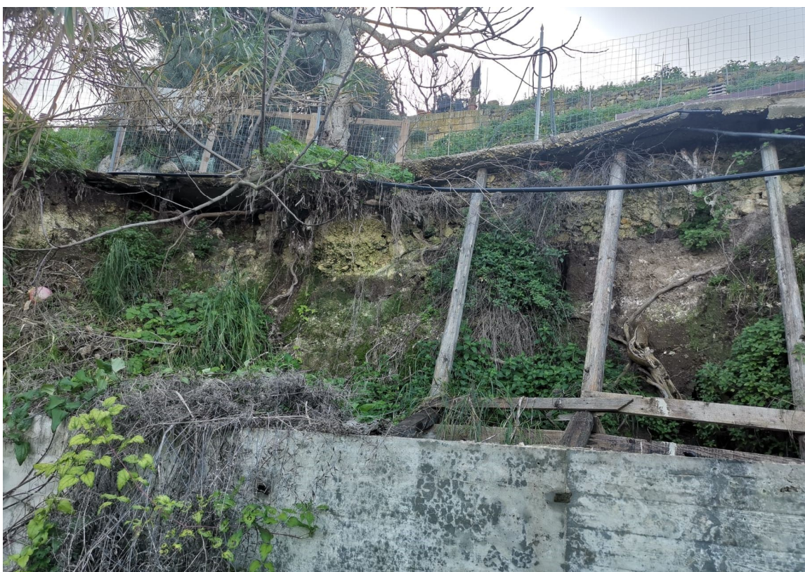
Figura 8 – Opere provvisorie di contenimento al di sotto del piazzale privato, in prossimità della fonte
