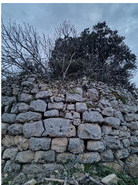
Foto 25: cedimenti delle pietre causati dalla vegetazione invasiva sul nuraghe
